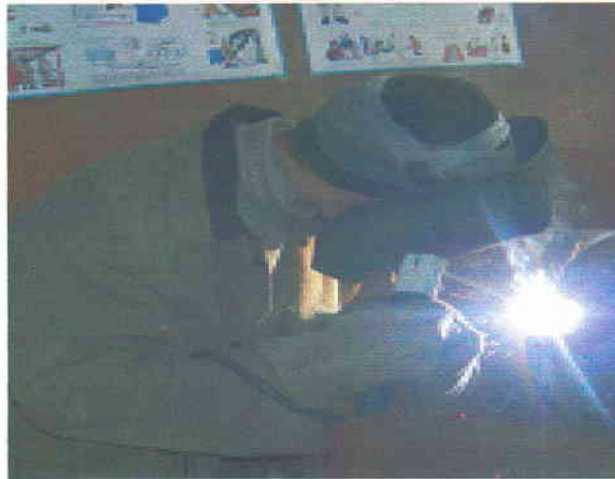
Рис.3 Сварка контрольного сварного соединения труб электродами PHOENIX 7018 .
