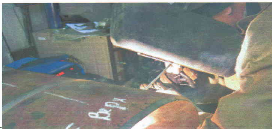
Рис.1 Сборка контрольного стыка труб
